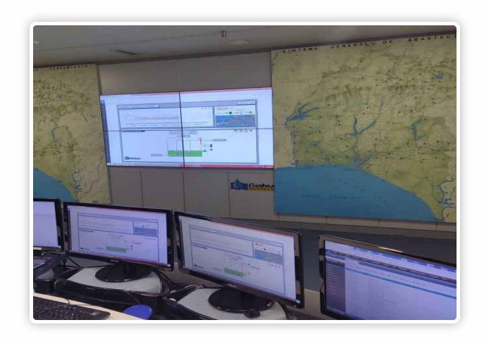
Giahsa utiliza la plataforma de Control Remoto Nexus que nos permite tener un control total sobre las infraestructuras, los tratamientos en las plantas de potabilización y depuración.
